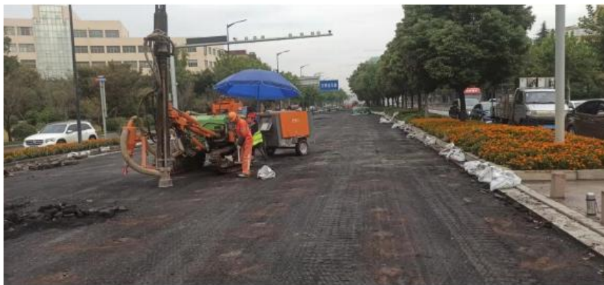
图二：打孔机施打注浆孔
