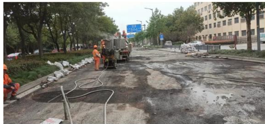
图三：注浆机对注浆孔进行注浆操作
