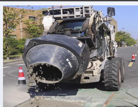
9、自密实混凝土按配比机械拌合
