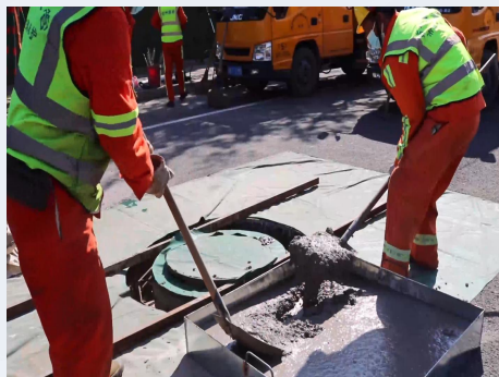
10、快速浇筑自密实混凝土
