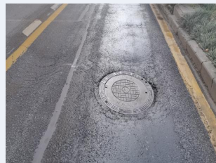
井周路面破损、环裂
