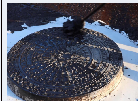
16、涂刷界面剂，井盖表面涂刷油水混合物
