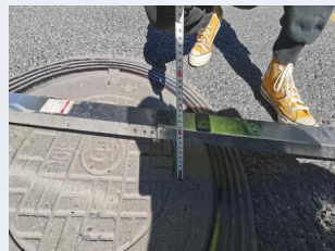
井周路面破损、环裂
