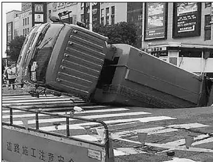
2020年6月30日 浦沿街道冠路口地面塌陷
