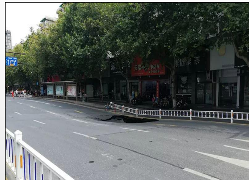
2019年8月28日 建国北路体育场路至凤起路段塌陷
